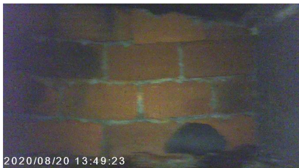
Obr. 3.41: Pravý nosník v 1. poli ; pohled po směru staničení skrz provedený odvodňovací otvor, dutina na konci nosníku nad opěrou O 01 zazděná
