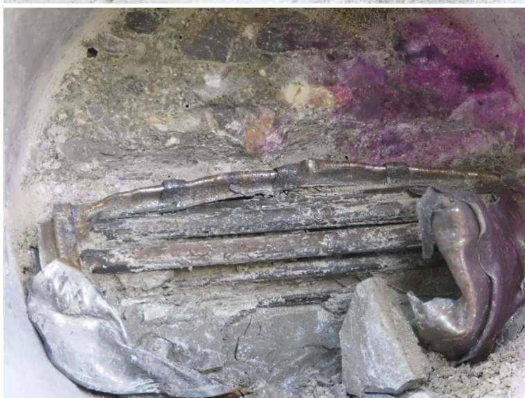
Obr. 3.32: Sonda P3 , kanálek plně zainjektovaný, injektáž suchá, mírná povrchová koroze drátů bez oslabení průřezu; předpínací kabel je ve "zdravém" nezkarbonatovaném betonu
