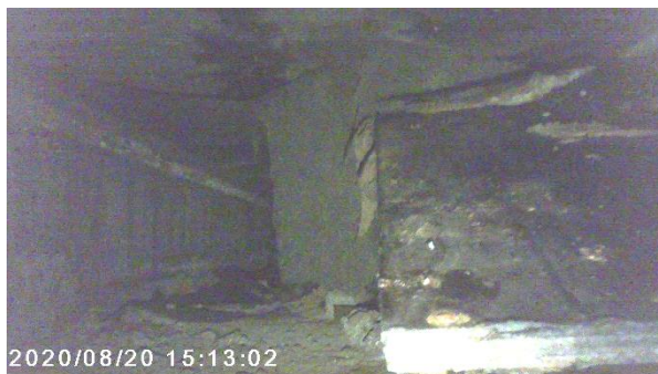
Obr. 3.38: Pravý nosník ve 3. poli ; pohled proti směru staničení skrz provedený odvodňovací otvor; ze stropu visí odtržený asfaltový pás; na stěnách stopy po zatékání; vápenné výluhy; místy odhalená korodující betonářská výztuž
