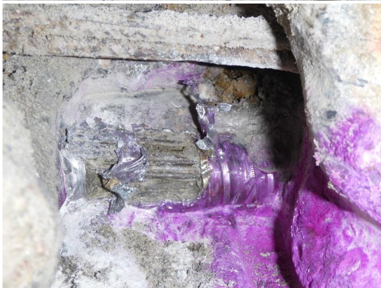
Obr. 3.26: Sonda P1 , kanálek plně zainjektovaný, injektáž suchá, dráty napadeny mírnou povrchovou korozí, dráty bez oslabení korozí; předpínací kabel je ve "zdravém" nezkarbonatovaném betonu
