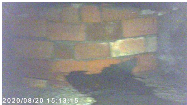
Obr. 3.37: Pravý nosník ve 3. poli ; pohled po směru staničení skrz provedený odvodňovací otvor, dutina na konci nosníku nad opěrou O 04 zazděná, na dně odtržený asfaltový pás
