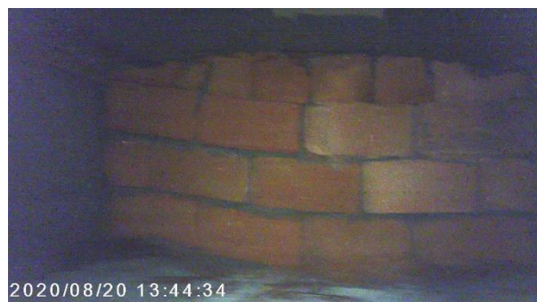
Obr. 3.35: Levý nosník ve 3. poli; pohled po směru staničení skrz provedený odvodňovací otvor, dutina na konci nosníku nad opěrou O 04 zazděná
