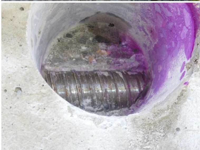
Obr. 3.31: Sonda P3 , kabel v ocelové chráničce; nepatrná povrchová koroze; krytí po chráničku 105 mm
