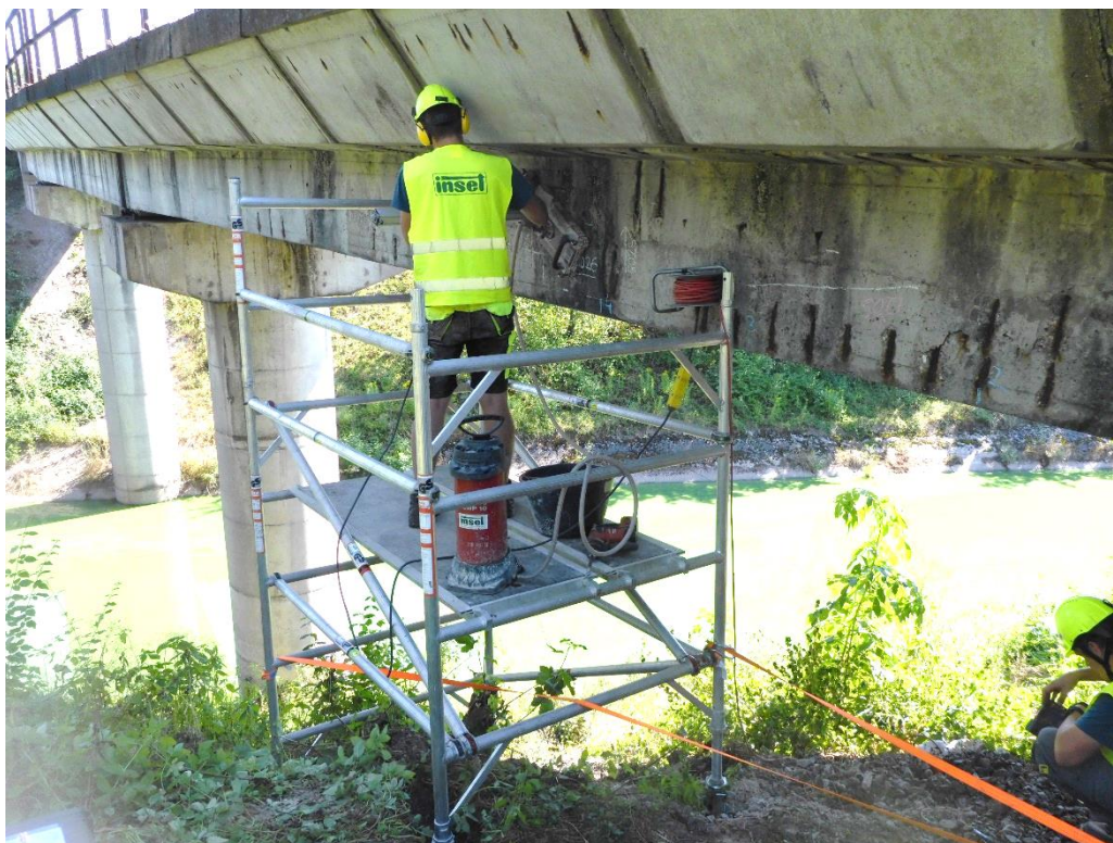
Obr. 3.1: Most zleva, 1. pole, z důvodu strmých svahů bylo nutné kotvení lešení do opěr
