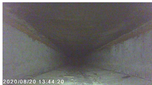
Obr. 3.36: Levý nosník ve 3. poli; pohled proti směru staničení skrz provedený odvodňovací otvor, v době prohlídky dutina suchá, místy stopy po zatékání ve formě vápenných výluhů
