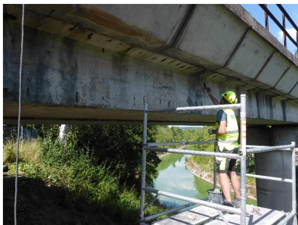
Obr. 3.13: Zapravení odvrty
