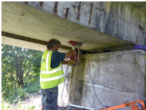
Obr. 3.34: Provrtání odvodňovacího otvoru do dutiny nosníku
