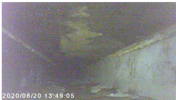
Obr. 3.42: Pravý nosník v 1. poli ; pohled proti směru staničení skrz provedený odvodňovací otvor; na dně leží odtržený asfaltový pás; na stěnách stopy po zatékání; vápenné výluhy
