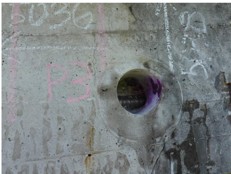
Obr. 3.30: Sonda P3 , byla provedena z boku pravého nosníku v poli 1 zleva cca v L_{1/3}
