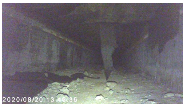
Obr. 3.40: Levý nosník v 1. poli ; pohled po směru staničení skrz provedený odvodňovací otvor, v době prohlídky dutina suchá, místy stopy po zatékání ve formě vápenných výluhů, ze stropu opět visí odtržené asfaltové pásy
