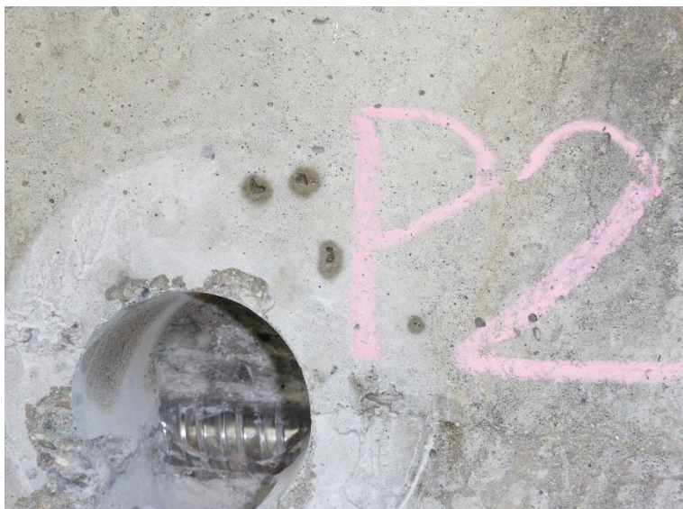
Obr. 3.27: Sonda P2 , byla provedena z boku levého nosníku v poli 1 zleva
