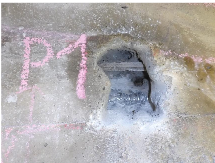
Obr. 3.24: Sonda P1 byla provedena zboku pravého nosníku v poli 3 v podélné mezeře mezi nosníky, před kanálkem v hloubce 60 mm 2 pruty betonářské výztuže Ø8; povrch betonu byl zamokřený; v hloubce 3 – 4 cm kaverna plná vody (po navrtání voda vytekla)
