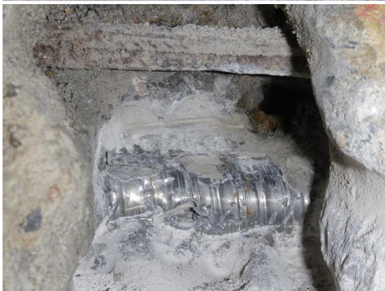
Obr. 3.25: Sonda P1 , kabel v ocelové chráničce; lokální povrchová koruze; krytí po chráničku 120 mm
