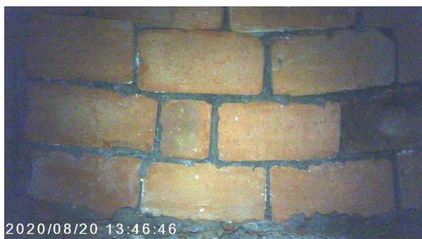
Obr. 3.39: Levý nosník v 1. poli ; pohled proti směru staničení skrz provedený odvodňovací otvor, dutina na konci nosníku nad opěrou O 01 zazděná
